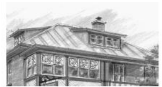
Toiture recouverte de tôle à baguette
