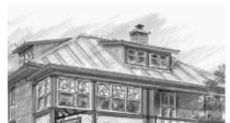
Toiture recouverte de tôle à baguette
